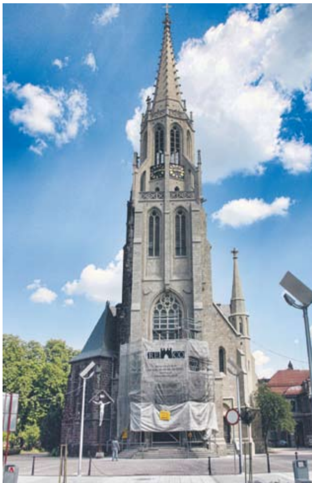
Kościół „Mariacki” Katowice. Elewacja w trakcie konserwacji
