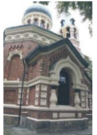
Cerkiew pw. Wiary, Nadziei i Miłości w Sosnowcu. Elewacja. Stan po konserwacji
